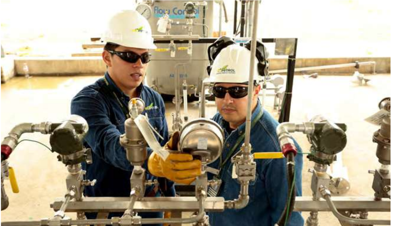
Trabajadores en la estación Acacias Departamento del Meta.
